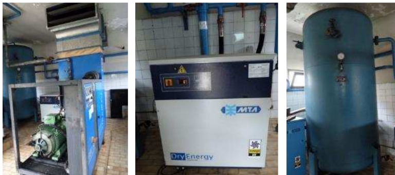
Slika 3-40 Osnovni elementi kompresorskog sustava – kompresor, sušać zraka, spremnik komprimiranog zraka
