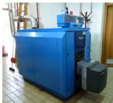
Slika 4-18 Niskotemperaturni kotao na EL loživo ulje proizvođača BUDERUS Logano GE515
