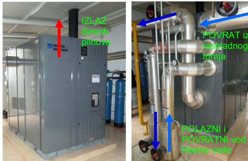
Slika 3-24 Plinski apsorpcijski rashladnik vode japanskog proizvođača EBARA RAP G-006 rashladnog učina 211 kW s otopinom litijbromid-voda kao radnom tvari
