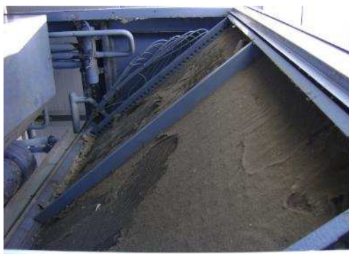
Slika 3-21 Onečišćena orebrena površina zrakom hlađenog kondenzatora kompresijskog rashladnog uređaja
