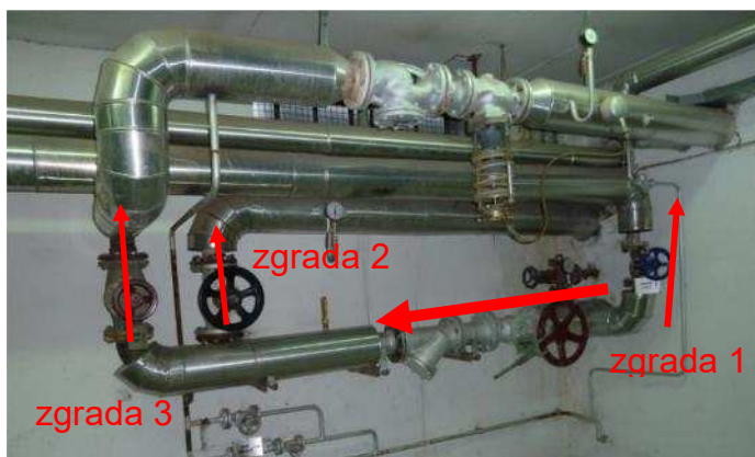
Slika 3-38 Podstava razvoda pare u zgradi
