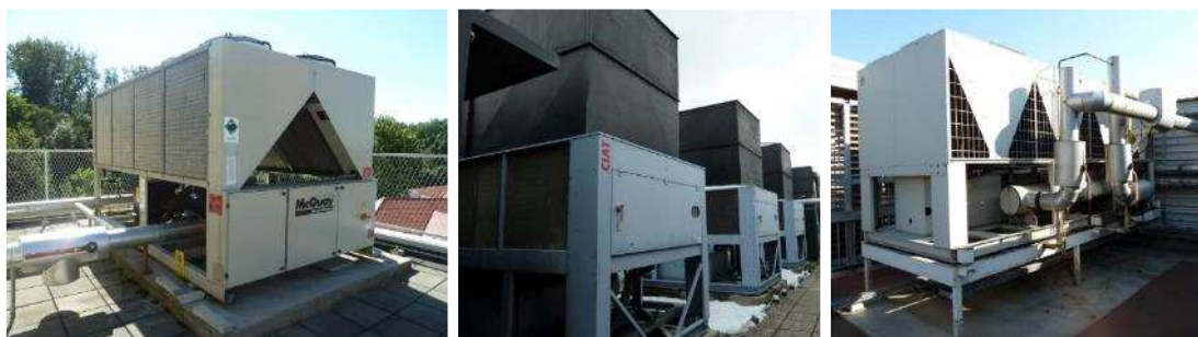
Slika 3-20 Kompresijski rashladni uređaji pogonjeni električnim motorom
