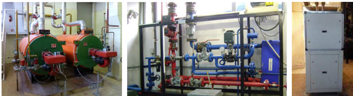
Slika 3-8 Uobičajeni izvori toplinske energije centralnog sustava grijanja
