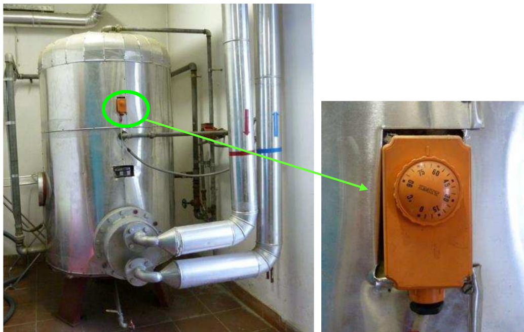
Slika 3-16 Spremnik potrošne tople vode volumena 1.000 litara za potrebe kuhinje
