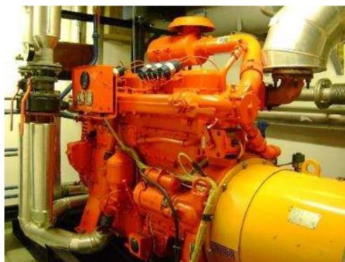
Slika 8-20 Kogeneracijsko postrojenje električne snage 75 kW i toplinske snage 150 kW na prirodni plin iz 2000. godine
