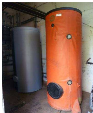
Slika 8-18 Dva solarna spremnika tople vode ukupnog volumena spremnika 2 \times 500 \text{ L} = 1.000 \text{ L}
