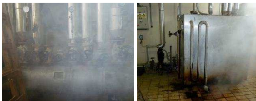
Slika 3-39 Razdjelnik pare s pripadajućim spremnikom kondenzata – neprimjereno stanje
