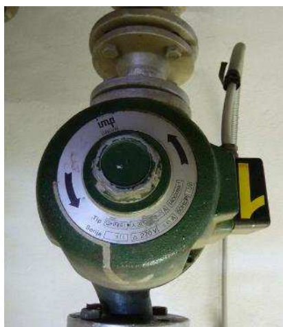
Slika 8-23 Crpka s konstantnim brojem okretajem (neregulirana)
