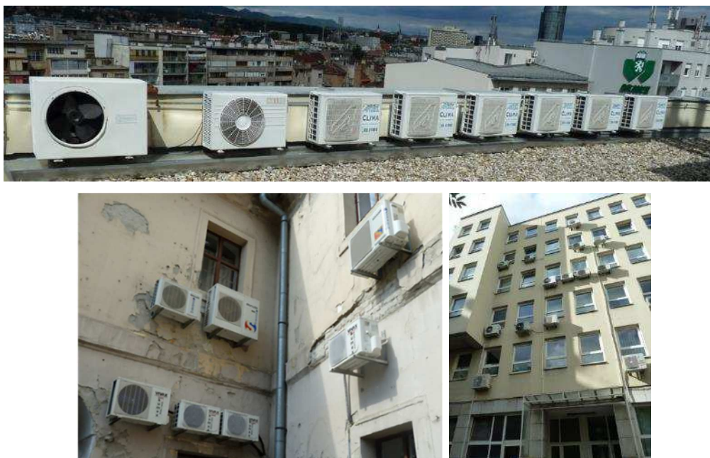
Slika 3-18 Decentralni sustav hlađenja pomoću pojedinačnih split klima uređaja
