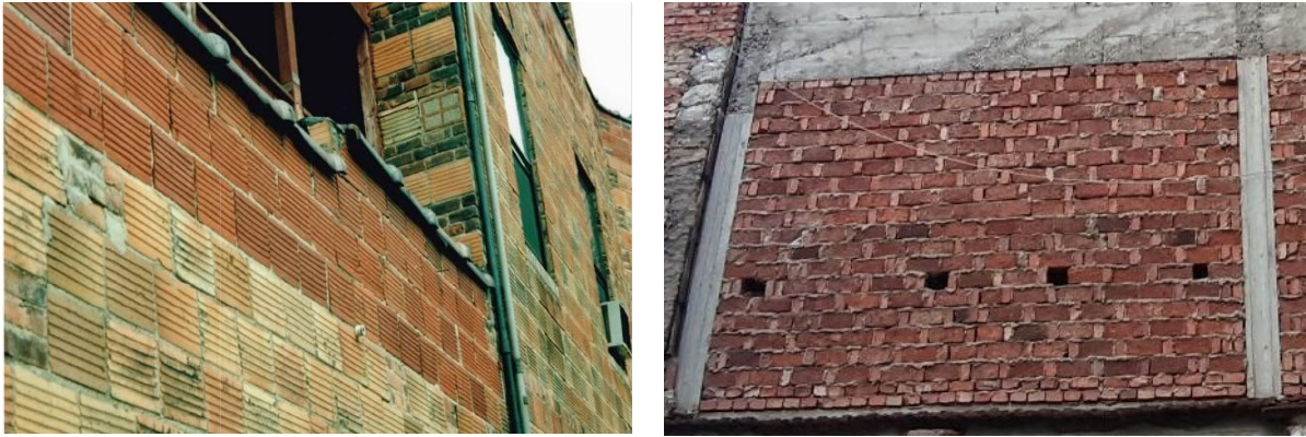
Slika 8 Primjer seizmički neprimjerenih zidanih zidova s blok opekom s horizontalnim šupljinama i šupljev zidanog zida od pune opeke
