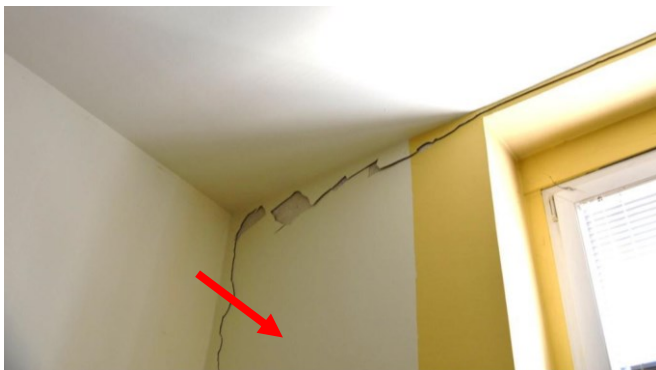
a) Pukotine na spojevima zidova i zidova sa stropom
