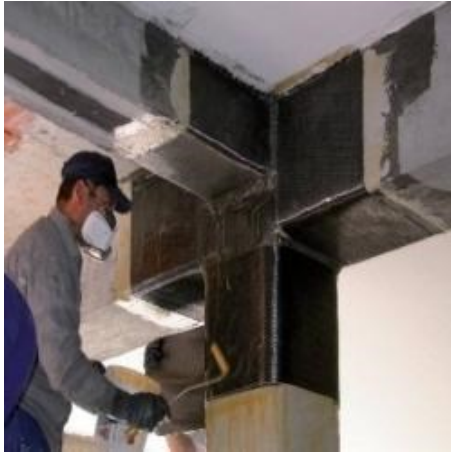
Slika 17 Skice pojačanja AB okvirnih konstrukcija ovijanjem čvorova FRP tkaninom i čelikom
