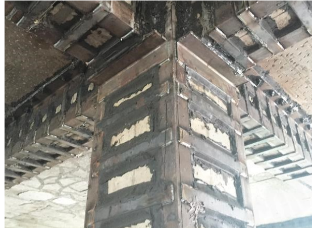
Slika 17 Skice pojačanja AB okvirnih konstrukcija ovijanjem čvorova FRP tkaninom i čelikom
