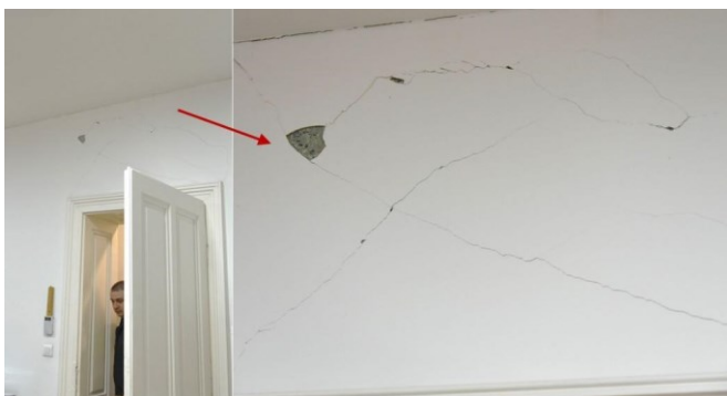
c) Pukotine u nosivim i pregradnim zidovima
