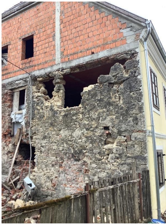
Slika 6 Fotografije degradacije zida zidanog od lomljenog kamena u potresu
