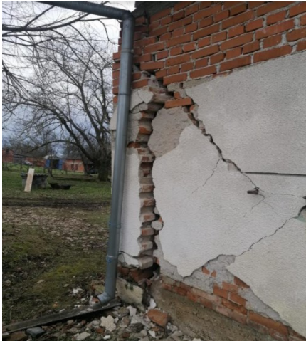
Slika 3 Fotografije oštećenja zgrada od nearmiranog ziđa s betonskim stropovima
