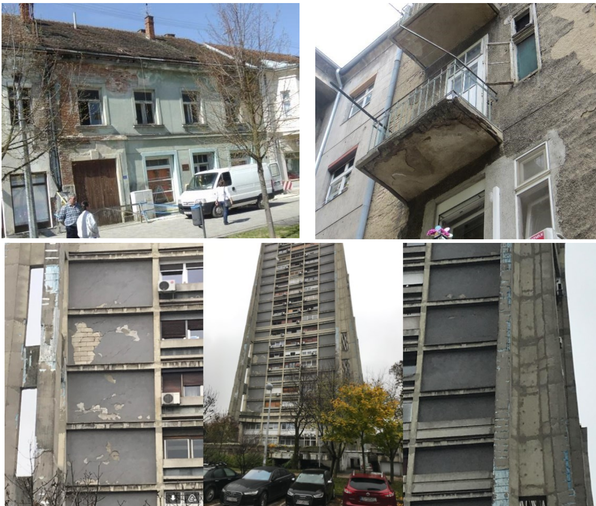
Slika 28 Primjeri oštećenja na zgradama uslijed dotrajalosti i neodržavanja
