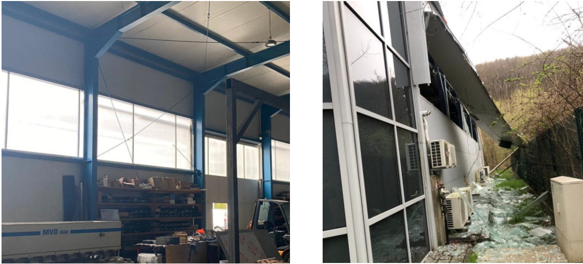
Slika 14 Fotografije otkazivanja dijagonala vezova u potresu, te oštećenja pročelja i stakala zbog velike fleksibilnosti okvirnih konstrukcija
