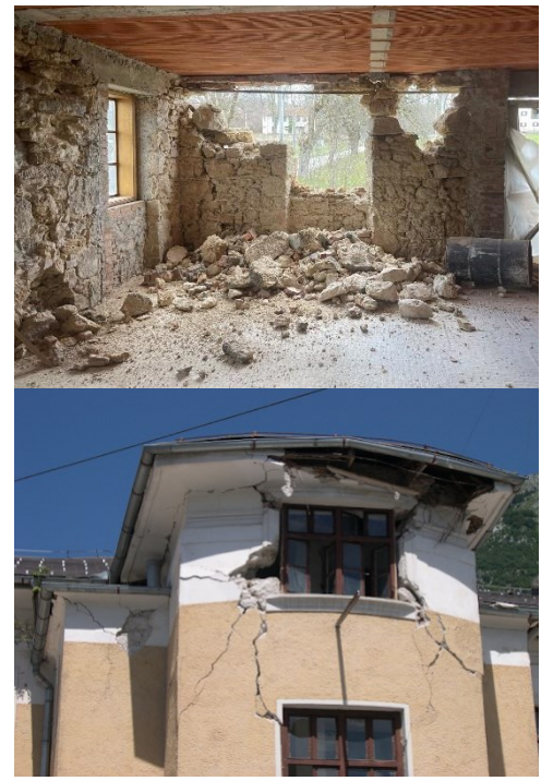
Slika 6 Fotografije degradacije zida zidanog od lomljenog kamena u potresu
