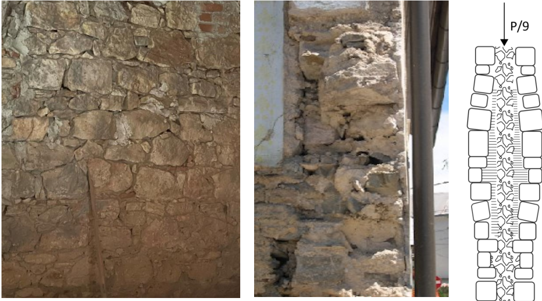
Slika 5 Fotografije zidanog zida od lomljenog kamena
