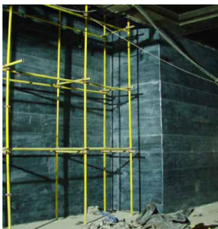
Slika 13 Primjer pojačanja postojećih AB konstrukcija ovijanjem FRP-om ili izvedbom dodatne AB obloge
