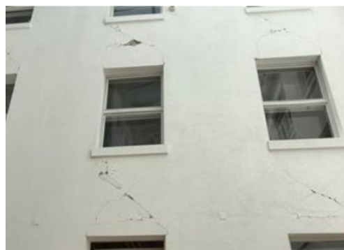
d) Pukotine na zidovima pročelja
