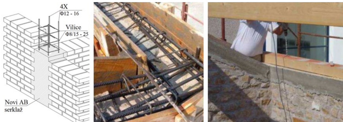
Slika 24 Pojačanje neomeđenih zidanih zidova izvedbom AB serklaža
